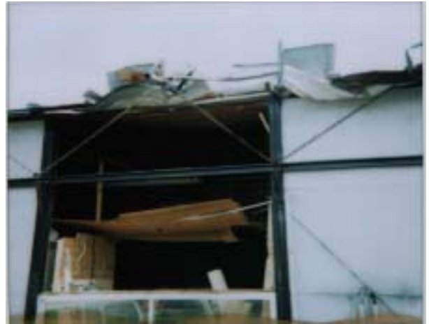
破壊された建物
